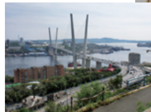
ウラジオストク・金角湾を横切るザラトイ橋
